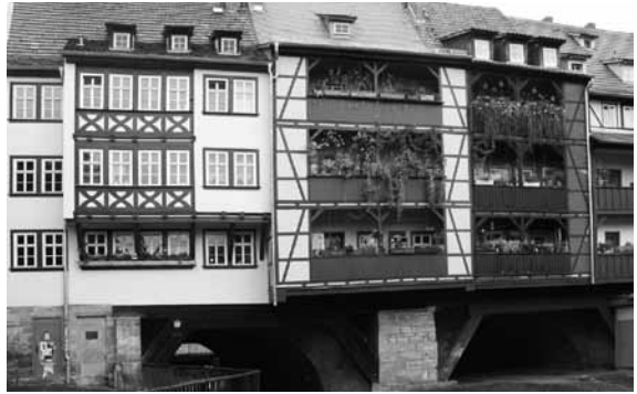
Krämerbrücke in Erfurt
